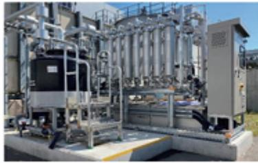
ろ過器逆洗水回収装置(海老名工場)
